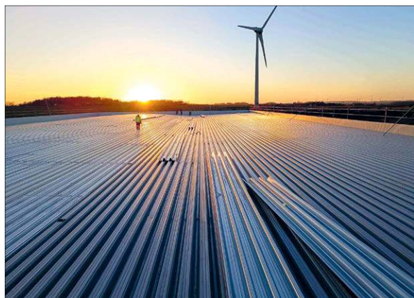
Jedną z usług wykonywanych przez firmę jest montaż stalowych pokryć na dużych powierzchniach
