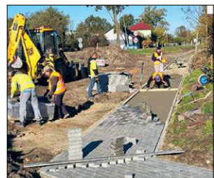
Prace przy budowie chodnika przy dw 812 w gminie Łomazy idą pełną parą
