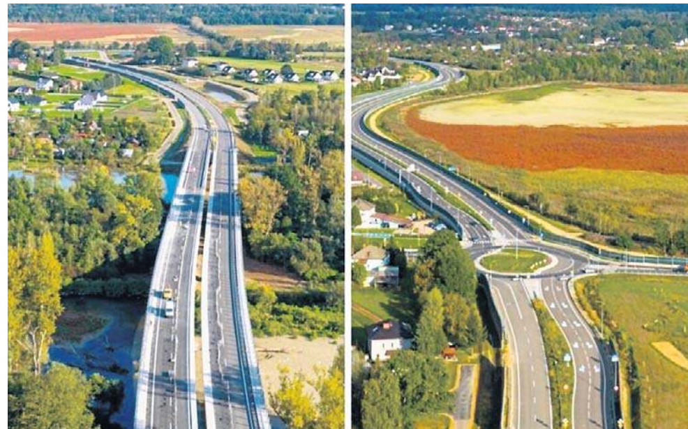
Obwodnica Oświęcimia gotowa jest na ponad 90 procent. Trwa budowa kluczowej części inwestycji przejazdu pod linią kolejową
