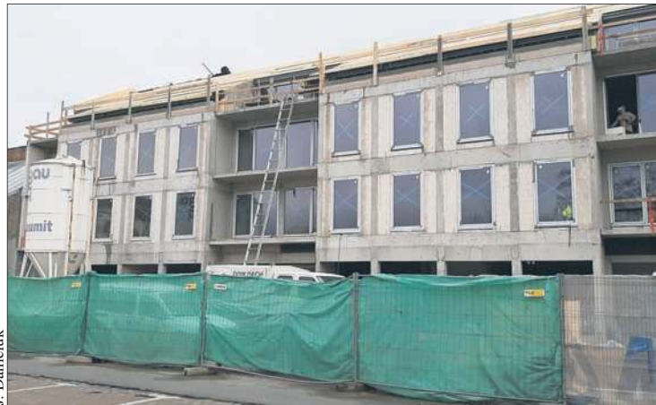
Trwa odbudowa kamienicy przy ul. Królewieckiej 18
