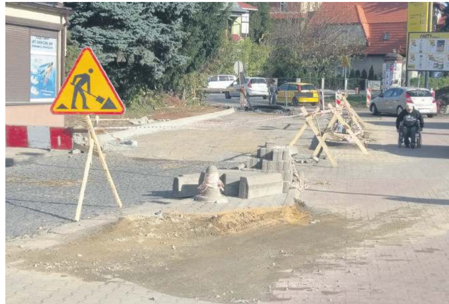
Trwający remont powoduje na razie utrudnienia przy wjeździe na ul. Fabryczną w Strzelinie, ale później powinno być dużo lepiej niż było
