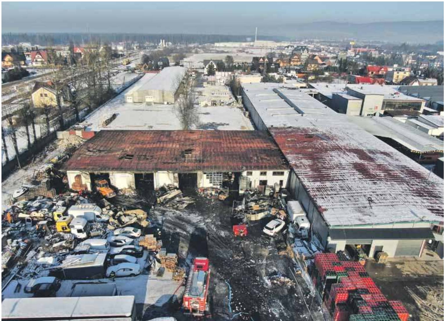
Tak spalony magazyn wyglądał dzień po pożarze z lotu ptaka.
