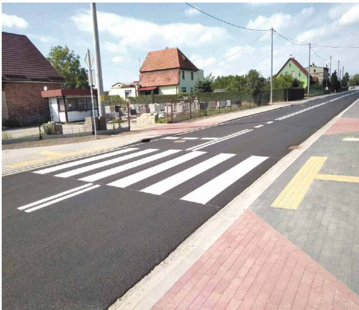
Dolnośląski Wojewódzki Nadzór Budowlany odebrał inwestycję 5 września i w tym samym dniu udostępnił ją kierowcom
