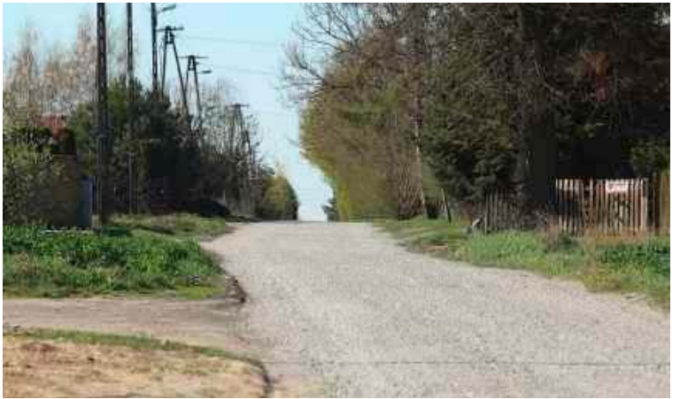
Na ulicy Drewnianej jeszcze w tym roku będzie asfalt, chodnik i kanalizacja
