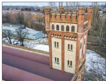
Zabytków czekających na odnowę na ziemi prudnickiej jest sporo. Wśród nich wieża ciśnień w byłym Froteksie w Prudniku.
