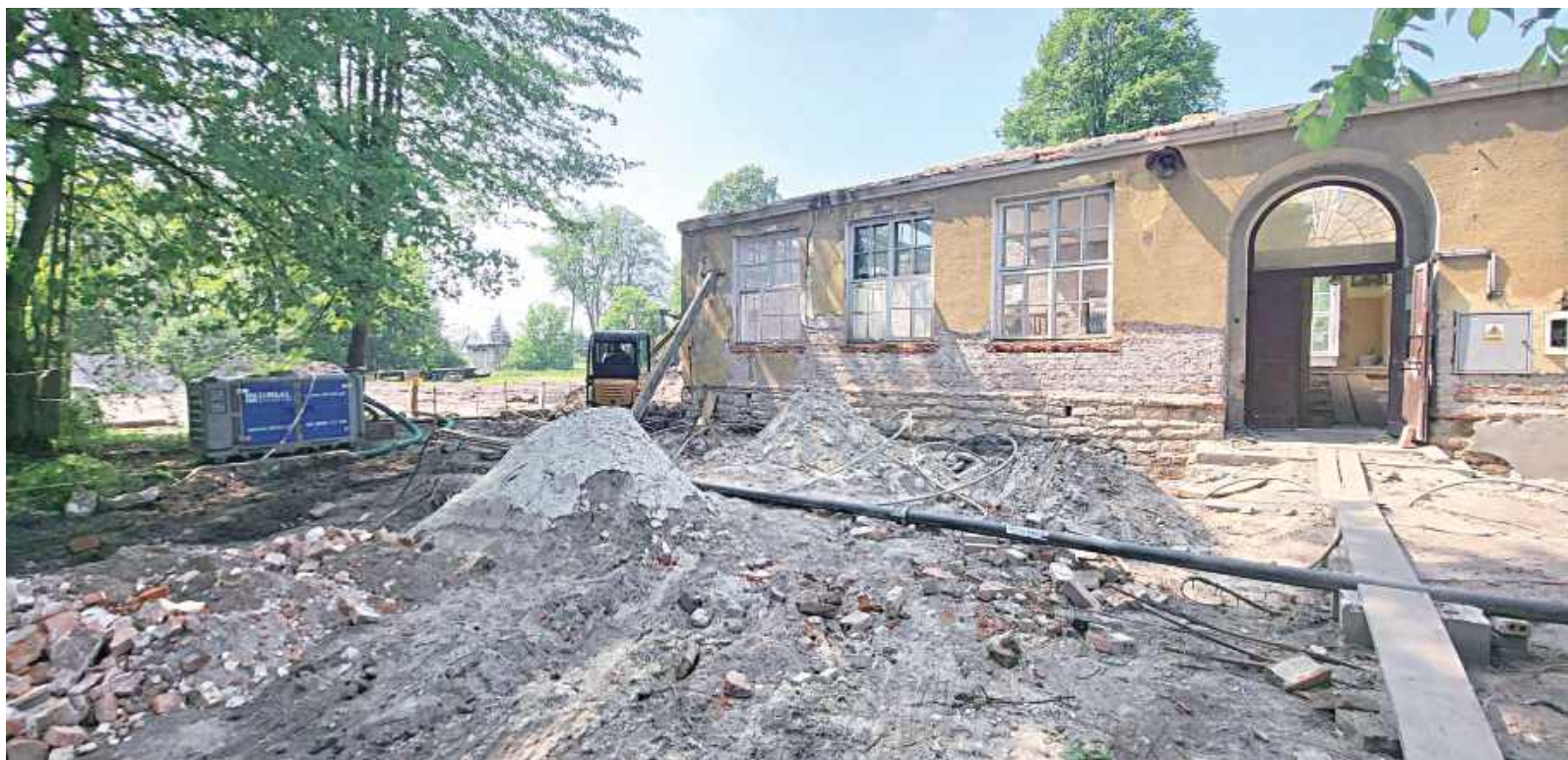
Tak wyglądał budynek w trakcie prac
