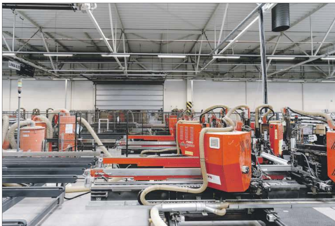
Nowoczesność, rozmach infrastruktury produkcyjnej i atrakcyjne zaplecze administracyjne to niektóre z atutów Eko-Okien SA
