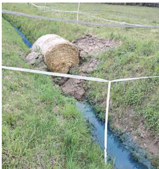
Teren przy zakładach Akzo Nobel w Pilawie
