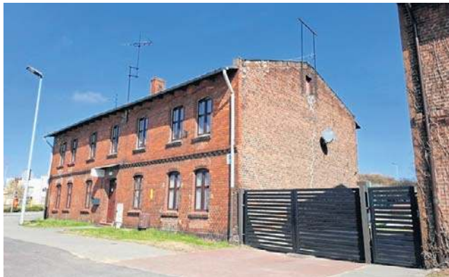
Lokatorzy kamienicy przy Szosie Chełmińskiej 110 zostali wykwaterowani
