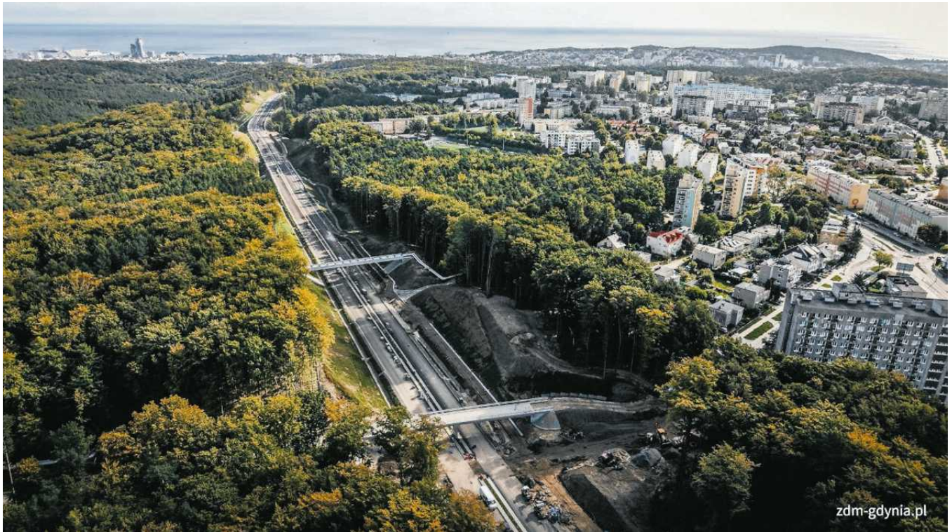
• Budowa obwodnicy Witomina
