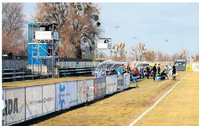
Nowa trybuna ma stanąć na miejscu starej
