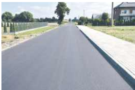
Przebudowana droga gminna w Fajstówkach
