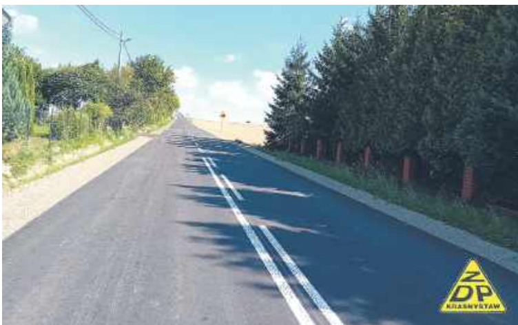
Rozbudowa drogi w miejscowości Borówek na terenie dwóch gmin Żółkiewka i Rudnik
