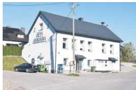
Budynek remizy OSP w Woli Idzikowskiej po termomodernizacji
