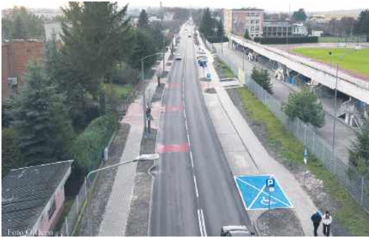
Przebudowa ulicy Piłsudskiego w mieście Krasnostaw
