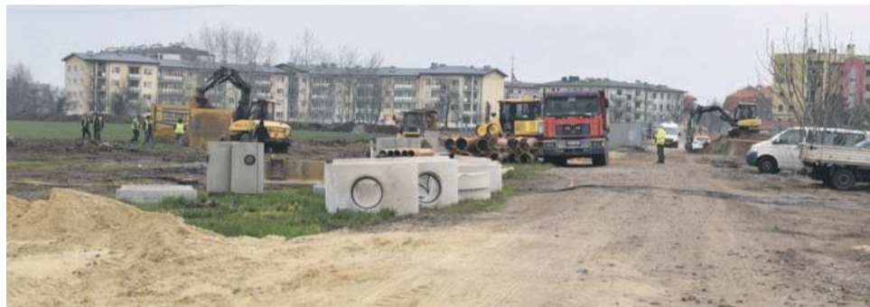
Drogi dojazdowe już powstają
