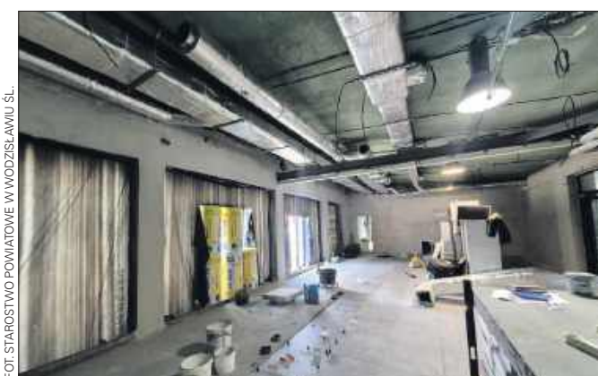
■ Budynek dawnej kotłowni w Zespole Szkół Technicznych w Wodzisławiu Śląskim przechodzi dużą metamorfozę. Za ponad 6,2 mln zł powstaną w nim pracownie związane z budownictwem i odnawialnymi źródłami energii.
