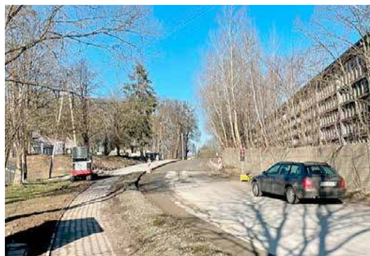
przebudowa ul Szpitalnej w Resku odbywa się dwuetapowo
