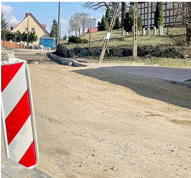
Droga Przytoń - Gościława czeka już tylko na nakładkę bitumiczną
