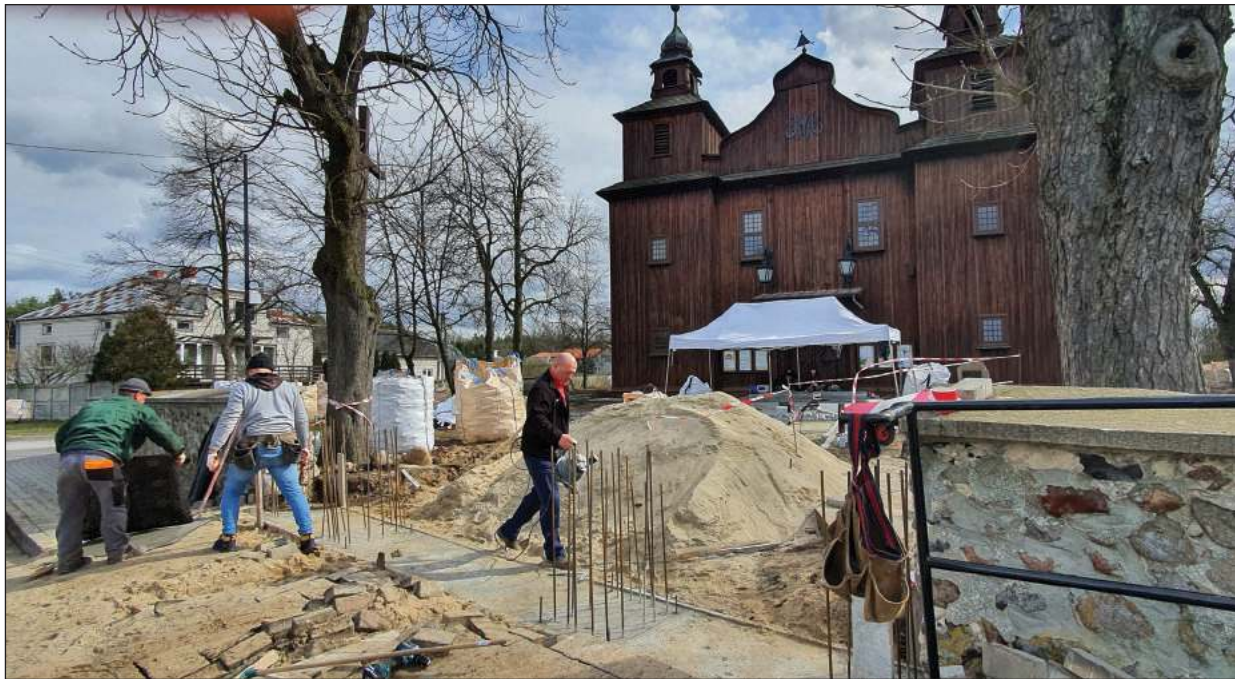
MARIANSKIE PORZECZE Trwa układanie nowej kostki granitowej na terenie kościelnym. Prace polegają na ułożeniu chodnika przy świątyni, schodów wejściowych do kościoła oraz opaski wokół budynku wraz z wykonaniem odwodnienia. Roboty rozpoczęły się trzy tygodnie temu i prawdopodobnie potrwać do Wielkanocy. Jak podaje ksiądz proboszcz Jan Krajewski, wyniosą one między 250 a 300 tysięcy złotych. Inwestycja zostanie pokryta z funduszy parafialnych i zakonnych
