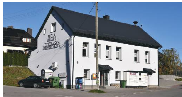
Budynek remizy OSP w Woli Idzikowskiej po termomodernizacji
