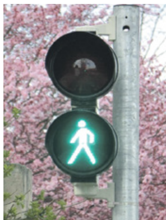
Środki można przeznaczyć m.in. na budowę przejść dla pieszych i sygnalizacji, remonty dróg czy instalację oświetlenia
