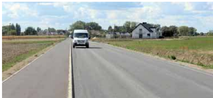
Teraz droga jest szersza, ma też nową nawierzchnię
