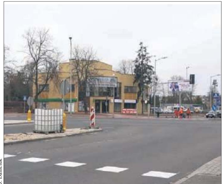
Skrzyżowanie ulic Łukasiewicza, Tysiąclecia i Miodowej po przebudowie
