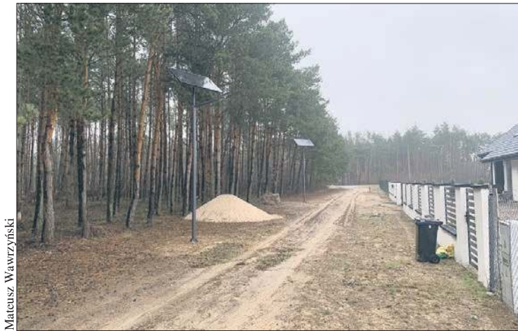
Już niebawem w wielu sołectwach powiatu płockiego zostaną zamontowane lampy solarne
