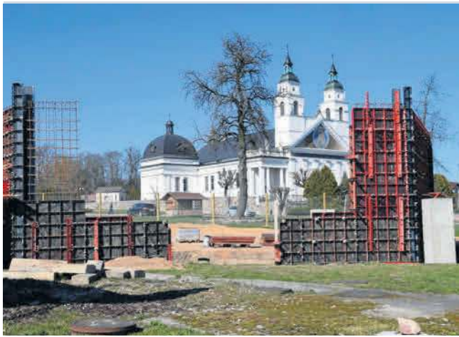
Prace nad budową ołtarza polowego ruszyły kilka tygodni temu. Obiekt ma być gotowy najprawdopodobniej już w czerwcu
