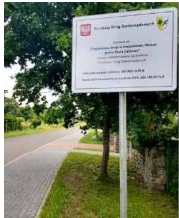
Z Funduszu Dróg Samorządowych wyremontowano m.in. drogę w Białuniu, w gminie Stara Dąbrowa
