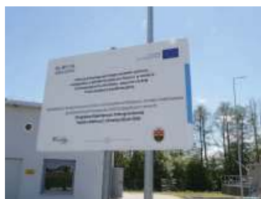
▲ Oczyszczalnia ścieków w Księżpolu
