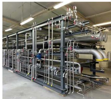
Fot. 2. Specjalistyczny most rurociągowy realizowany dla branży farmaceutycznej
