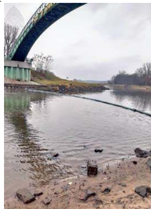
Jedną z zapór strażacy rozłożyli na wysokości kładki (fot. PSP w Nowej Soli)
