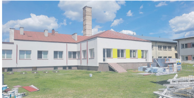
Szkola w trakcie remontu
