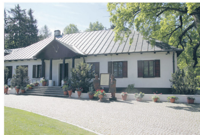
Dom Pracy Twórczej „Reymontówka” w Chlewiskach
