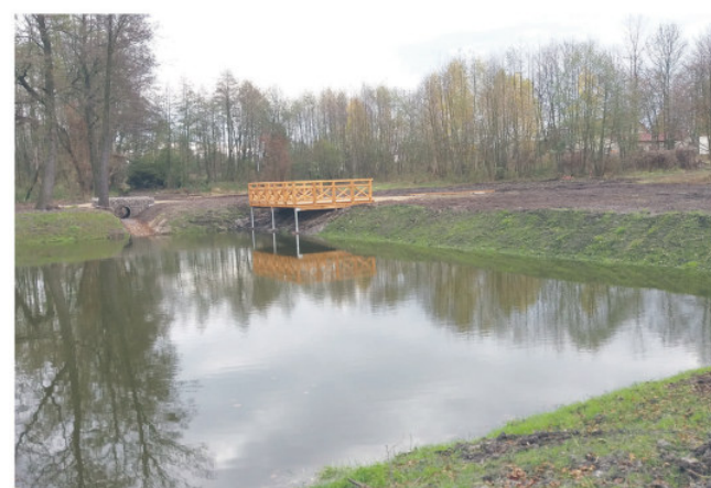
Zbiornik wodny na terenie Specjalnego Ośrodka Szkolno-Wychowawczego
