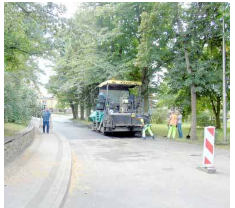
Stan robót - poniedziałek, godz. 12.00
