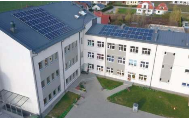
Szkoła Podstawowa im. 100 – lecia Niepodległości Polski otrzymała nagrodę specjalną. Inwestor: Gmina Głusk. Biuro Projektowe: P.H.U. „MS PROJEKT”. Wykonawca: BUDIMEX S.A., Warszawa
