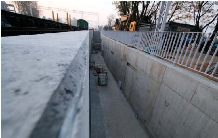
Dzięki modernizacji linii pasażerowie zyskali nowy przystanek kolejowy Lublin-Zachód na Czubach
