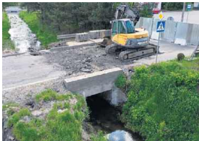
Przepust w Hutkach. Na razie prace stoją, droga jest nieprzejezdna
