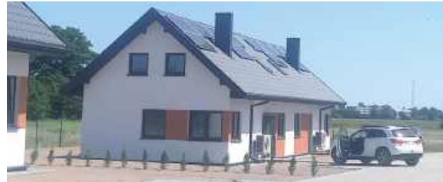
Na parterze, o powierzchni około 60 mkw., znajdują się dwa pokoje, salon z aneksem kuchennym oraz łazienka. Poddasze pozostawiono do indywidualnej aranżacji mieszkańców. Budynki wyposażono m.in. w pompy ciepła oraz instalacje fotowoltaiczne, co ma pozwolić ograniczyć koszty eksploatacji. Jako dodatkowy atut wymieniany jest ogrodzony teren osiedla, mający zapewnić mieszkańcom poczucie bezpieczeństwa i prywatności
