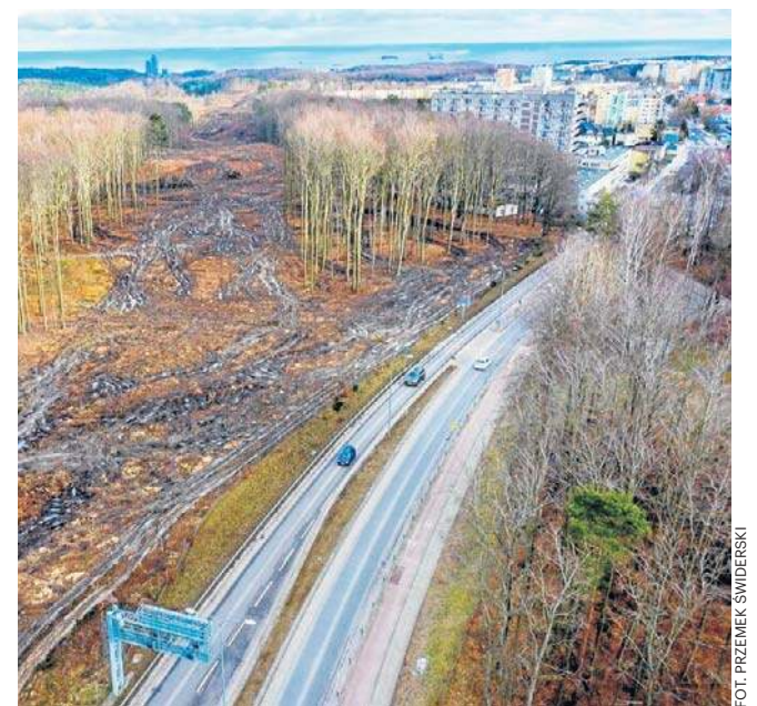
Wykonawca rozpocznie roboty od wrywania karpin, następnie rozpocznie prace ziemne
