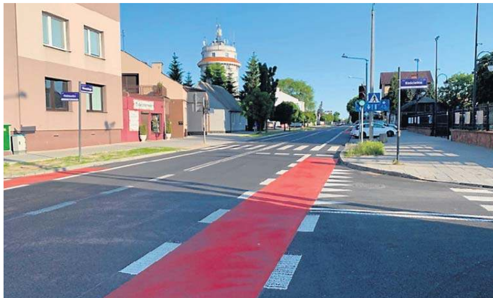
Tak prezentuje się obecnie ulica Słowackiego w Radomiu po zakończeniu wszystkich prac. To jedna z kilkunastu ulic w tej części miasta, na których trwały prace.
