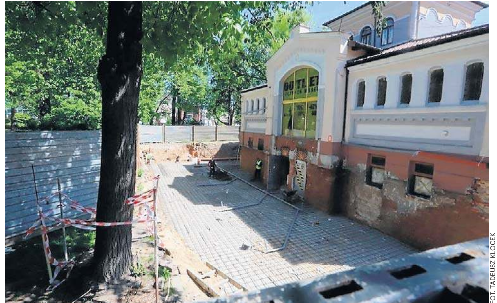
W Domu Towarowym Senior trwają obecnie prace związane z zabezpieczeniem budynku przed zalewaniem wodami opadowymi.
