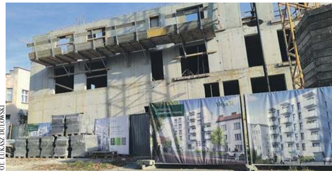
Budowa obiektu wielorodzinnego przy alei Henryka w Chrzanowie
