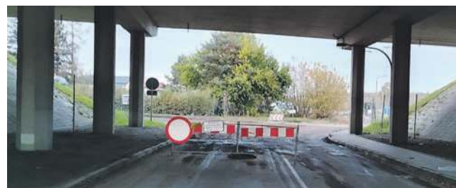
Zakaz ruchu pod wiaduktem na Wodzińskiej w Chrzanowie
