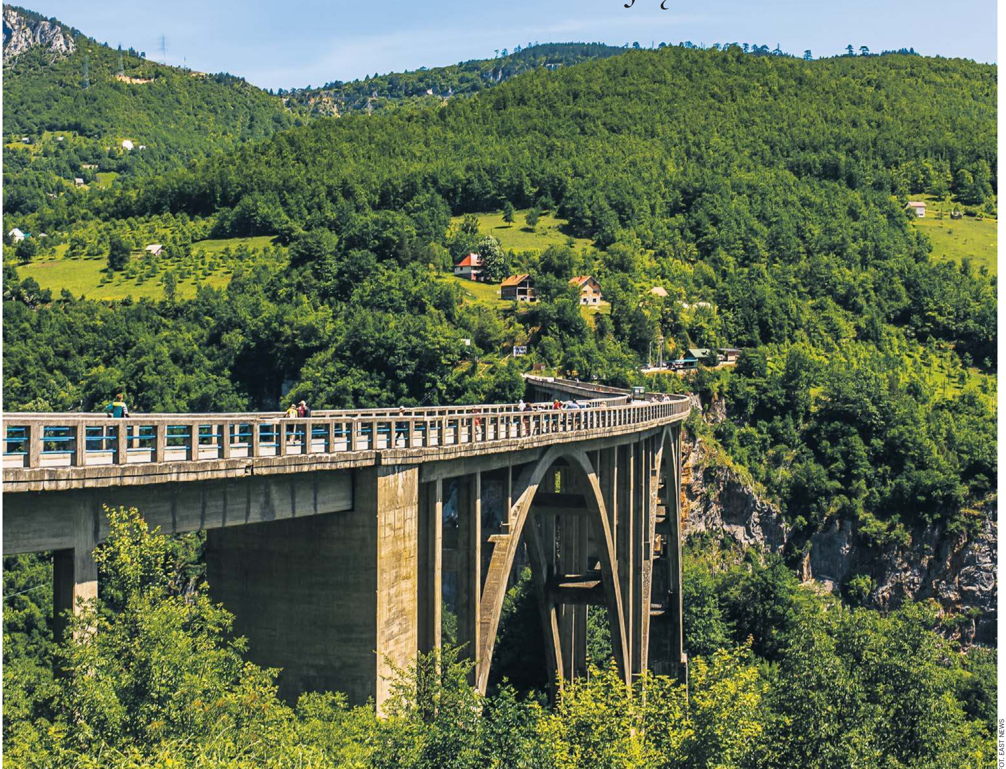
Niesamowity widok na most Durdevića Tara nad kanionem rzeki Tara w Czarnogórze
