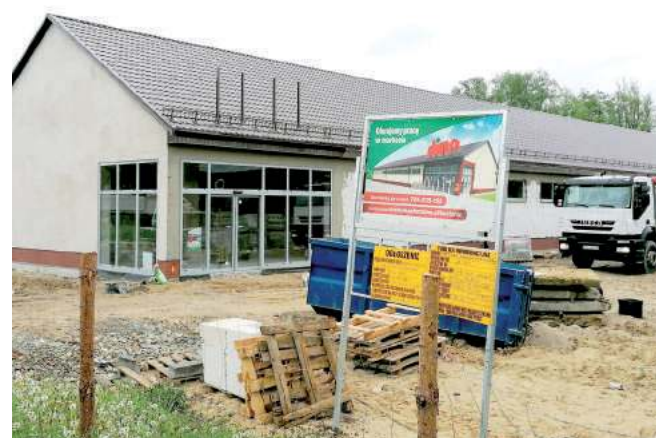
Market Dino powstaje w Urzędkowie. Mieszkańcy zwracają uwagę na bardzo szybki postęp prac na budowie
