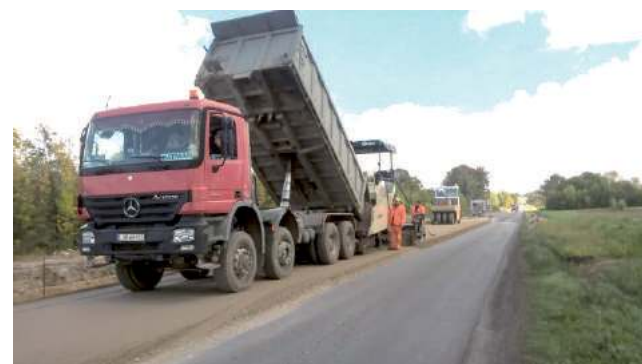
Na remontowanym odcinku jezdni jest poszerzana do 7 m z jednoczesnym wzmocnieniem jej konstrukcji
