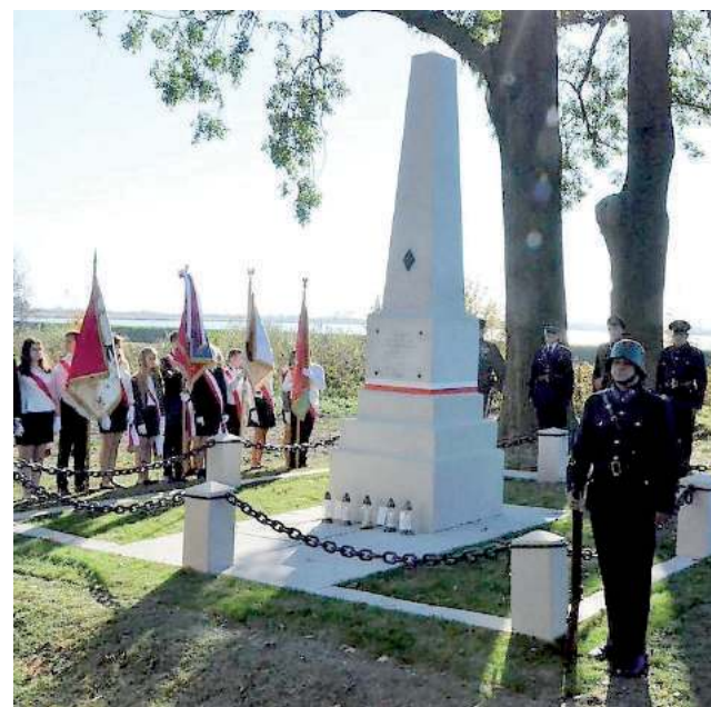
Oprócz tego, że pomnik zyskał nowy blask, specjalną masą uzupełniono w nim ubytki i zabezpieczono obelisk przed czynnikami atmosferycznymi. Obelisk mierzący około 5 m wykonany jest z bloków piaskowca, spojenych zaprawą wapienno-piaskową
