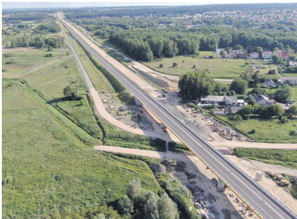
Prace przy budowie drugiej nitki obwodnicy Tomaszowa Lubelskiego są zaawansowane w 50 procentach.
