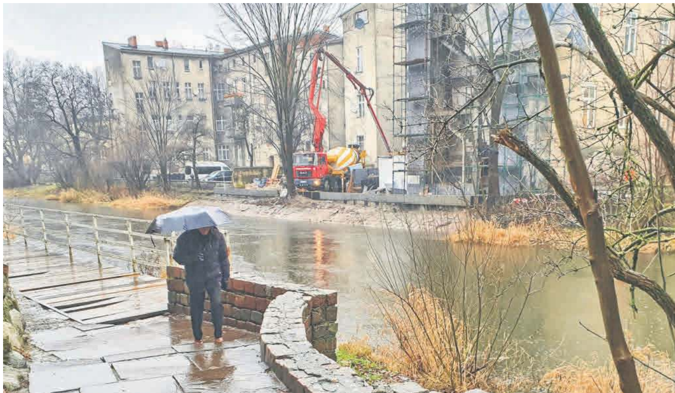
Obok remontów istniejących mostów wybudowane zostaną też kładki. Jedną z nich zepnie ulicę Szarych Szeregów z biblioteką miejską. Realizację inwestycji obliczono na dwa lata.
