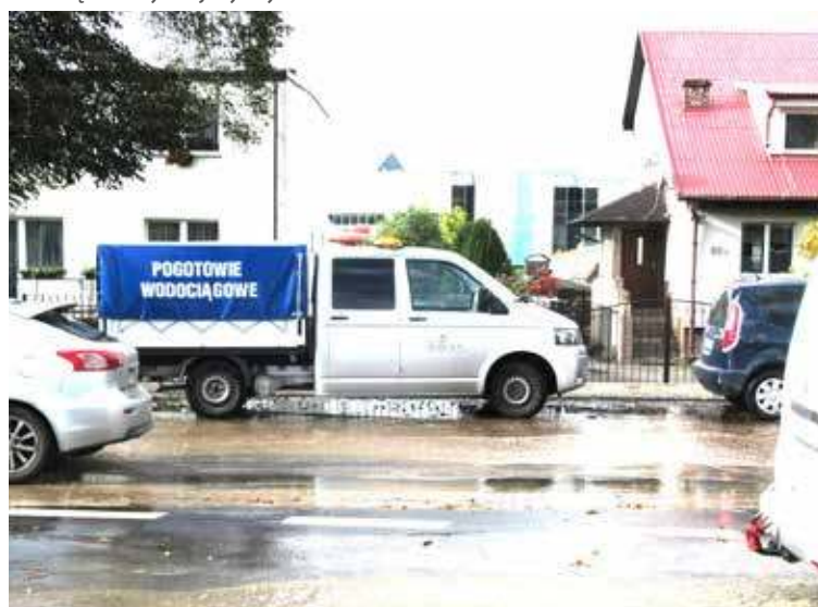
Pogotowie Wodociągowe pracowało w kilku miejscach
