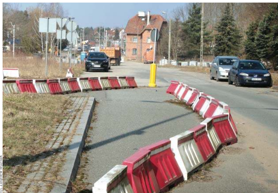
Nowobałtycka ma się zaczynać w miejscu, gdzie teraz stoi ten budynek
