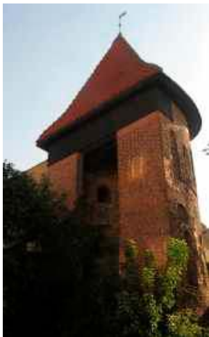
Po remoncie i konserwacji XIV-wieczna baszta zyska iluminację
