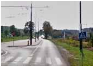
Blisko 500-metrowy odcinek chodnika powstanie wzdłuż ulicy Józefa Franczaka „Lalka” na wysokości osiedla „Nowy Felin”
