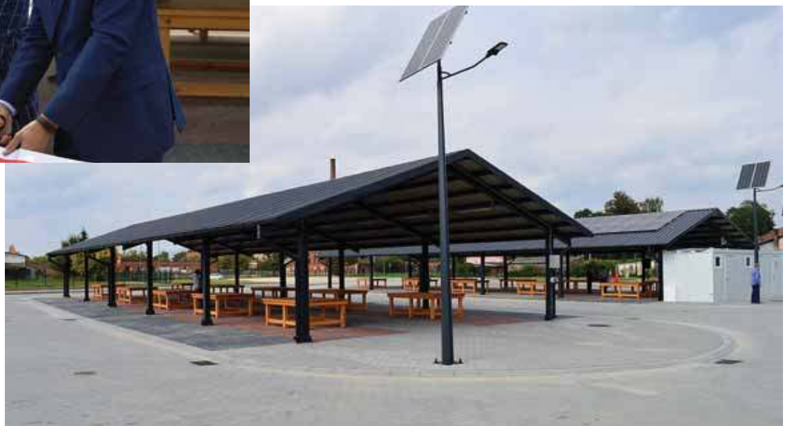
Zmodernizowany obiekt posłuży lokalnym handlarzom i społeczności.
