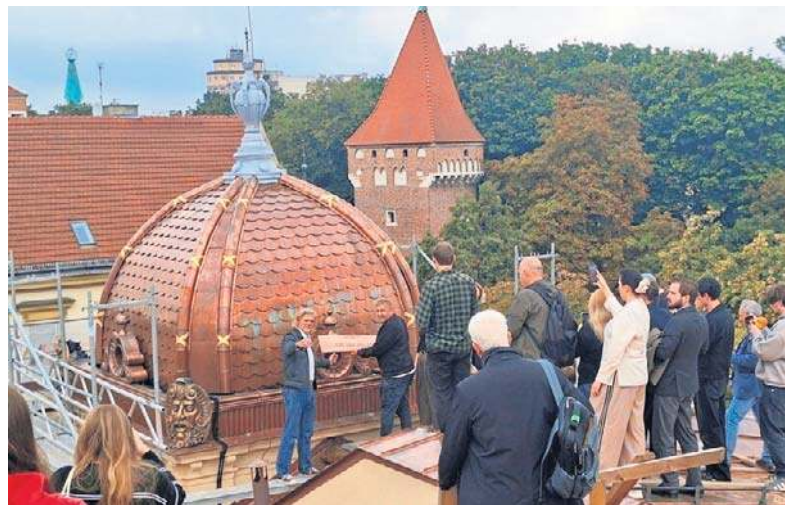
Dach Teatru Słowackiego jest już wymieniony w całości
