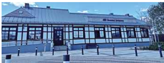
Zabytkowy dworzec PKP w Pilawie przeszedł gruntowną modernizację, która zakończyła się na przełomie kwietnia i maja 2024 roku
