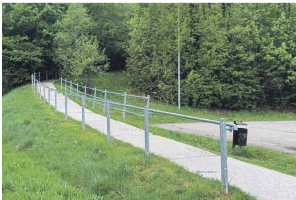
Zakres prac przewiduje przebudowę całej konstrukcji zejścia na odcinku o długości 149 metrów.
