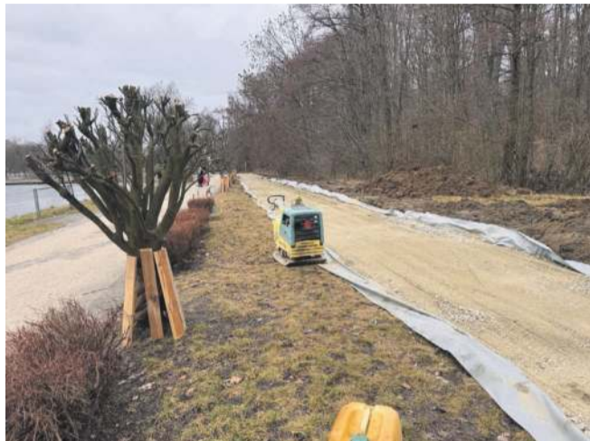
Tak wyglądała budowa podczas rozpoczęcia inwestycji
