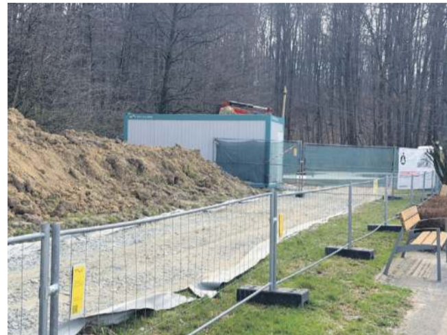
Pojawiło się ogrodzenie drogi tymczasowej drogi, ale prace zamarły
